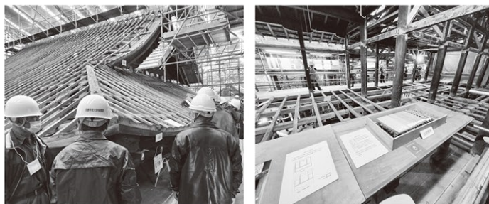
知恩院 重要文化財 勢至堂修理工事現場
